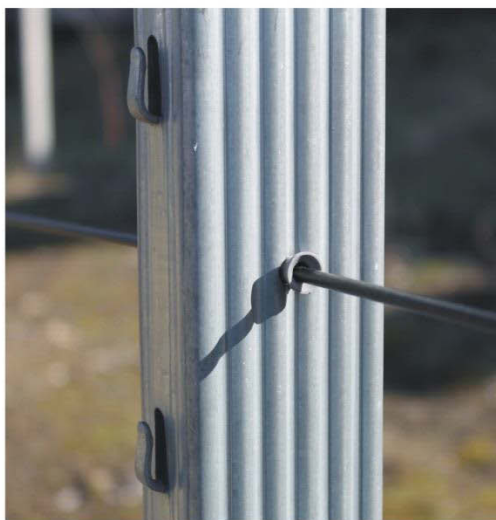
Установка троса через пластиковый дюбель
