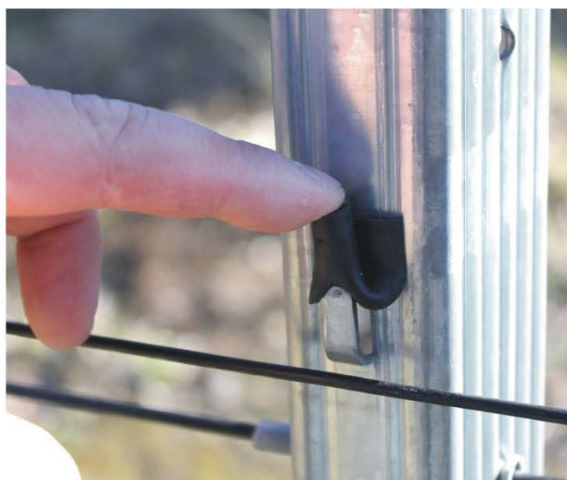
Установка защитного кембрика
